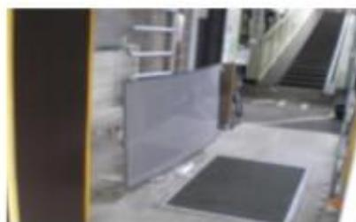
写真-4 電波吸収体 (写真中央)
