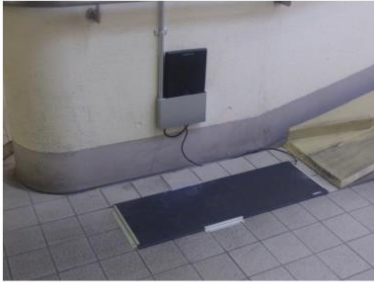
〔設置例1〕①壁据え付け型アンテナ+②マットアンテナ<場所>階段 B 踊り場
