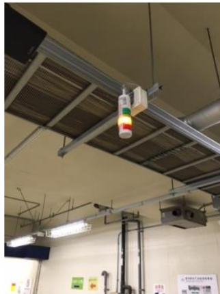
〔設置例3〕④天井据え付け型アンテナ<場所>地下 1 階階段 A 周辺
