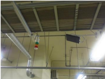
〔設置例3〕④天井据え付け型アンテナ<場所>地下 1 階階段 A 周辺
