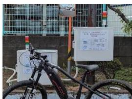
①アンテナ装置（写真）を、ポールに上下にずらして2台設置（写真）。この前を通る自転車に取付けられたICタグの情報を読取る。
